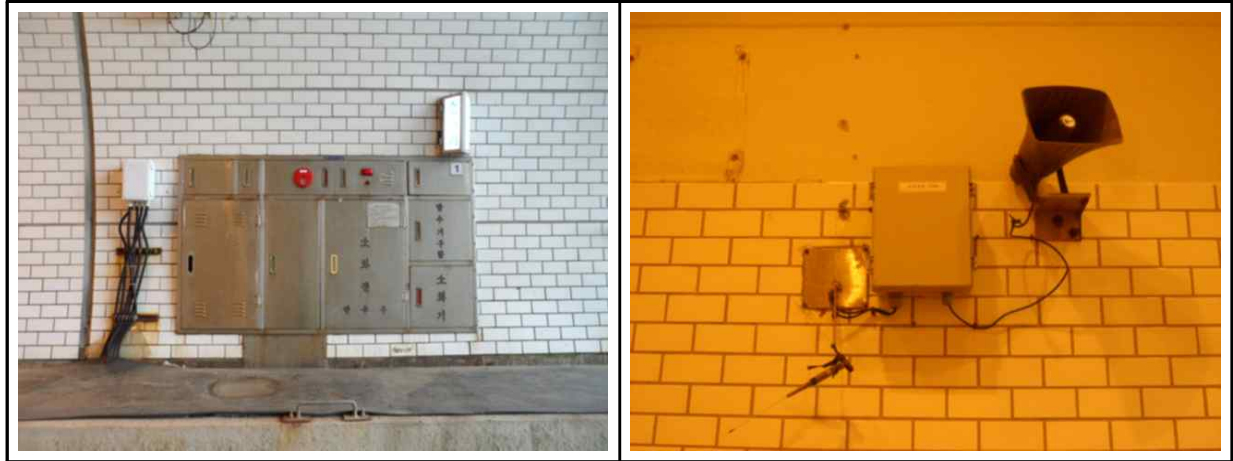
【사진 2.3.19】 기타부속시설 전경
