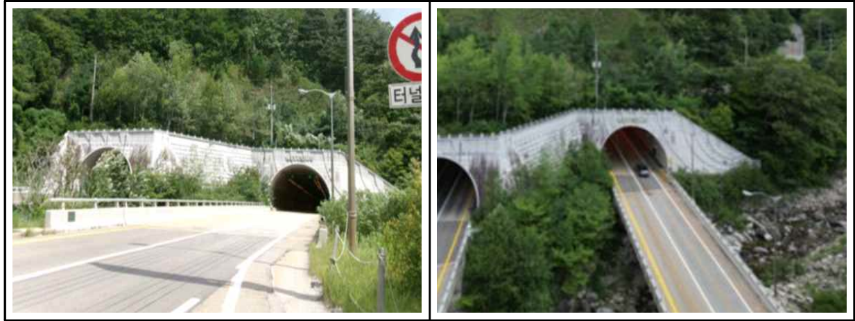
【사진 2.3.11】 옹벽 전경
